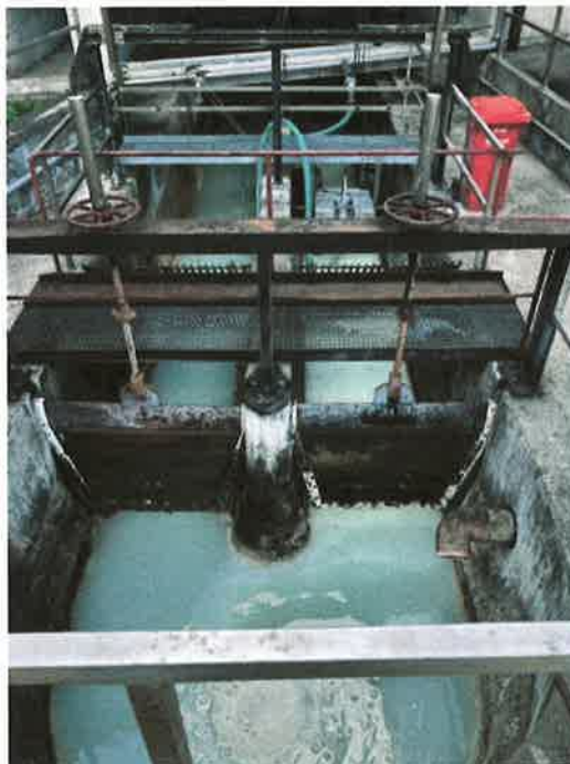
Abbildung 2: Kombination aus Sandfang, Rechen und Fettabscheider
