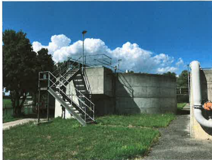
Abbildung 3: Seitenansicht des Denitrifikationsbeckens
